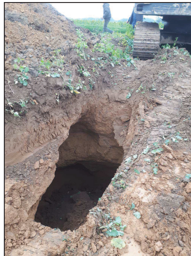
Photographie 2 : Remontée de fontis mise à jour correspondant à l'indice n°50bis lors du décapage de l'indice 50 à quelques mètres de ce dernier
